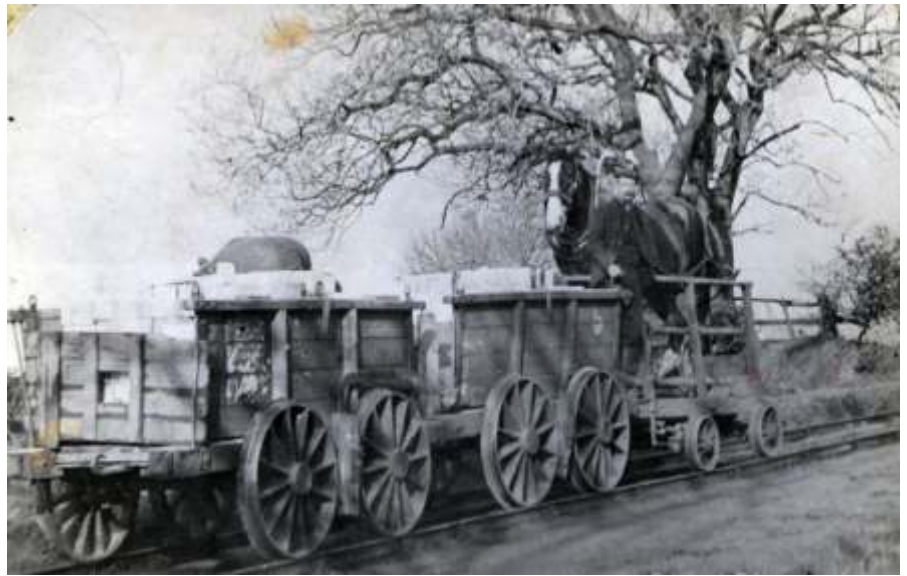
Zwei mit Ziegelsteinen beladene Wagen des Ziegelwerks Throckley auf der Talfahrt Richtung Fluss. Am Schluss des Zuges ein Dandy Cart mit Pferd und Kutscher. Das Foto ist von 1909.
