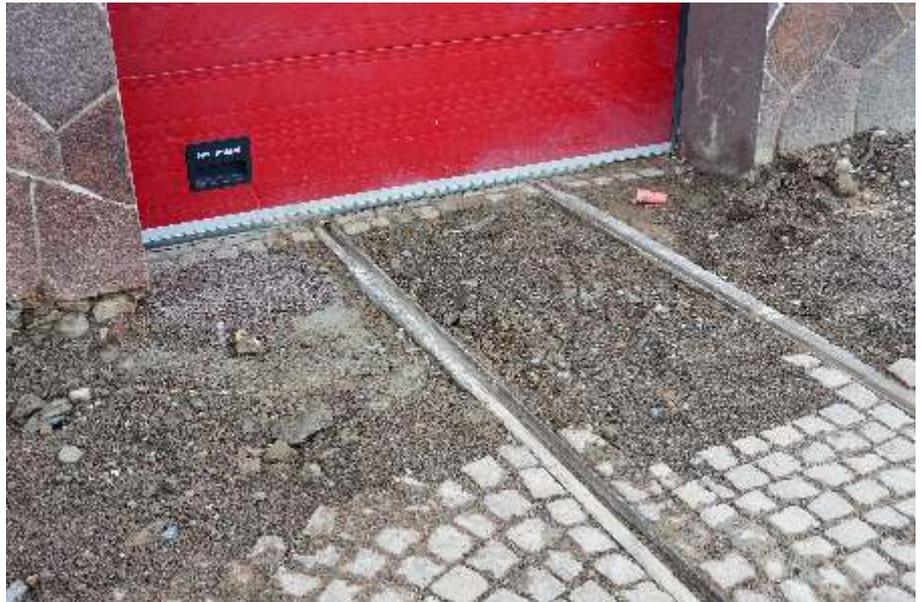
Hochdruck-Betoninjektion zwischen den Gleisen zur Verstärkung des Fundaments
