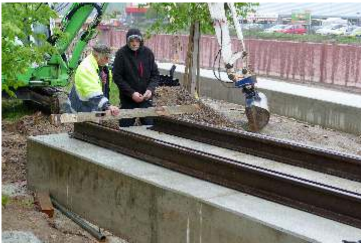
Alfred Klepzig und Stefan Klaer montieren die Schienen auf dem Betonfundament
