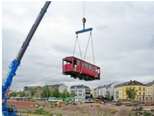
Der Autokran hebt den Neuchâtel Wagen um das Museumsgebäude herum und setzt ihn auf das Fundament
