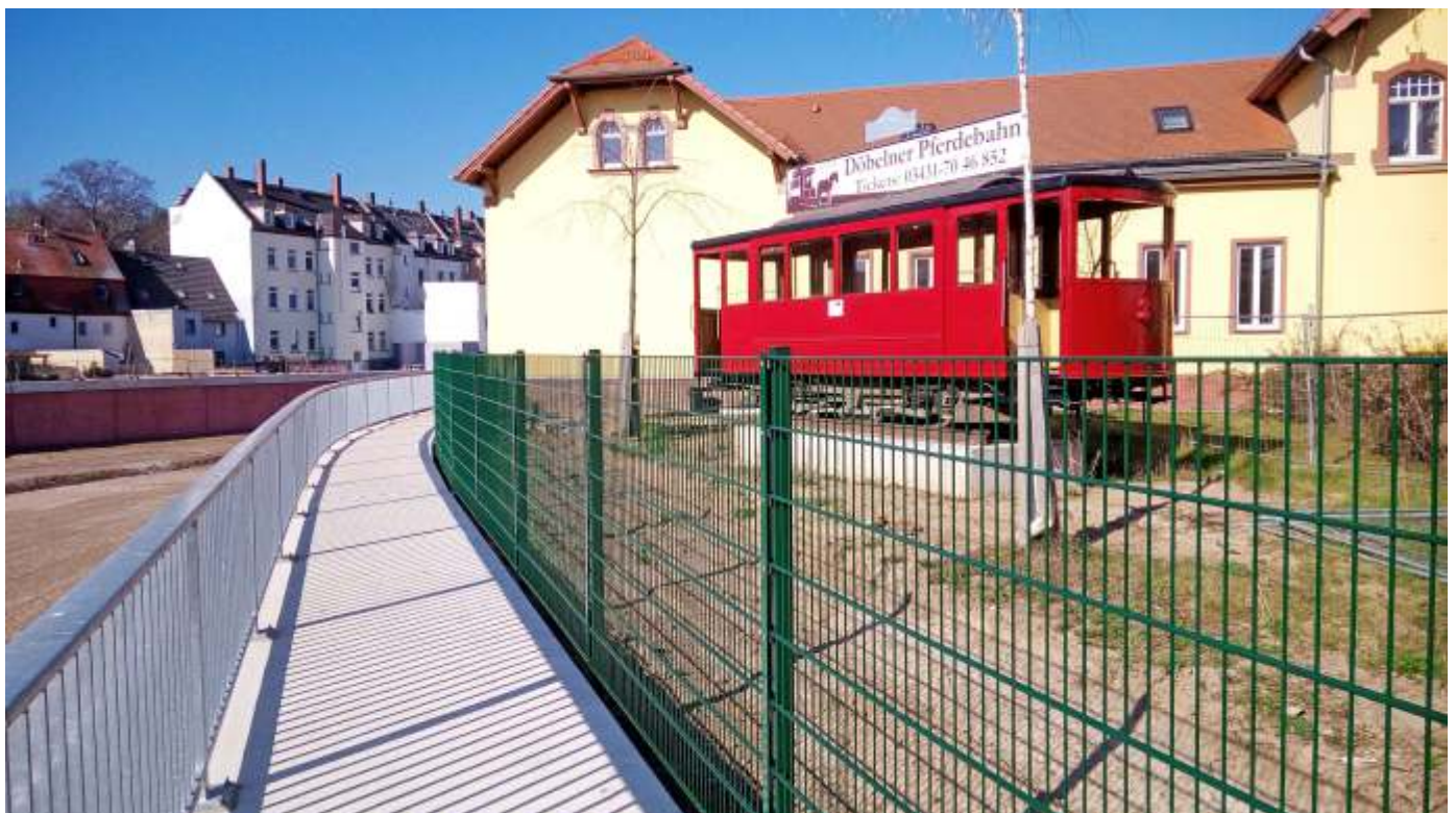
Anfang April bot sich vom neuen Gehweg an der Flutmulde dieser Blick auf das Pferdebahnmuseum
