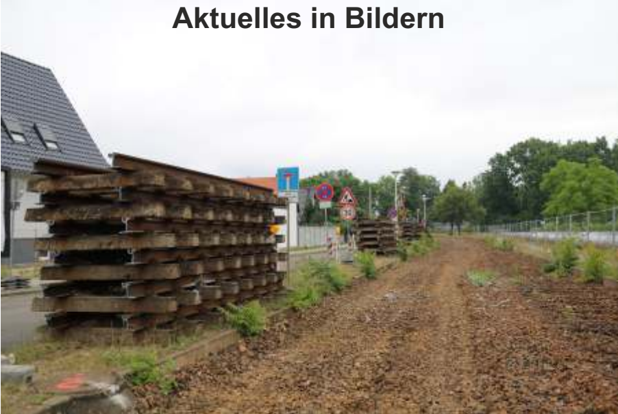
Unsere „neuen“ alten Schienen hier nach dem Abbau in Cottbus Foto Ulrich Thomsch
